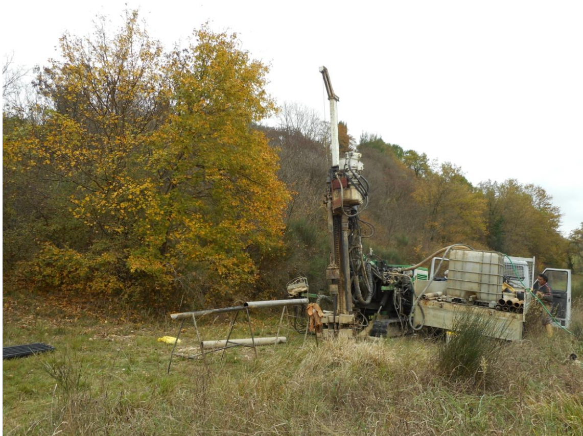
Foto n° 8 – Ubicazione Sondaggio geognostico
